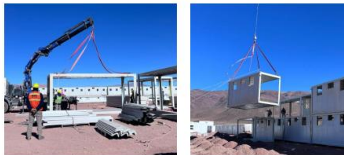
Imagen 6- Armado y montaje de módulos del piso superior
