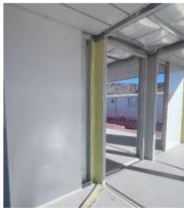
Imagen 7- montaje de paneles.
