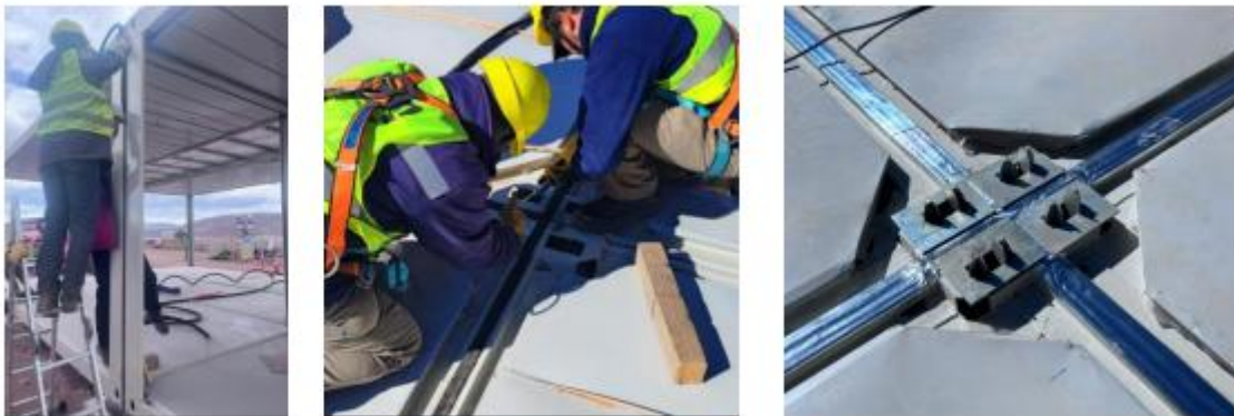
Imagen 4- Montaje de burletes y membrana
