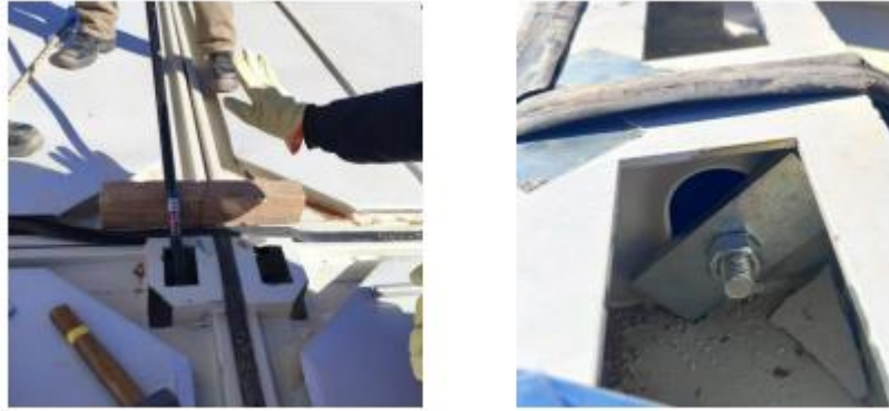
Imagen 3- Nivelación de estructura
