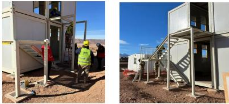
Imagen 5- Montaje de escalera
