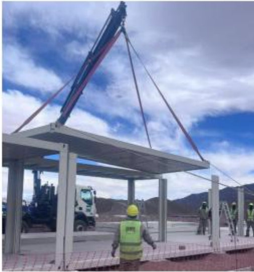
Imagen 2- Montaje de techo
