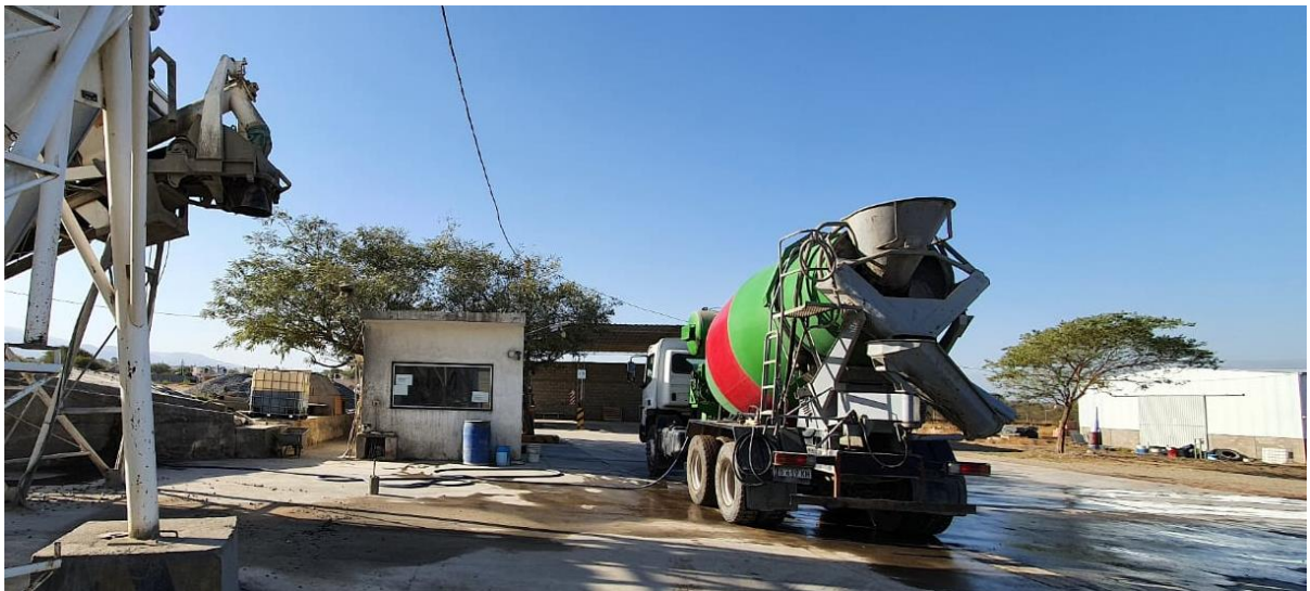
Imagen N° 29: Planta dosificadora de hormigón sector de carga.
