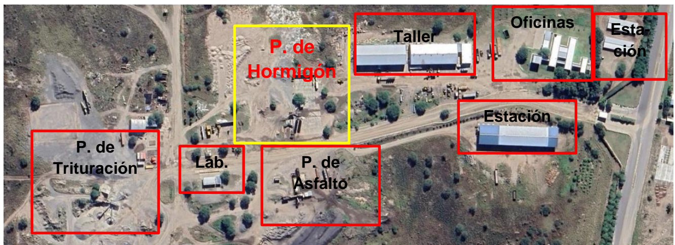
Imagen N° 3: Identificación de sectores en el predio de la Empresa.
