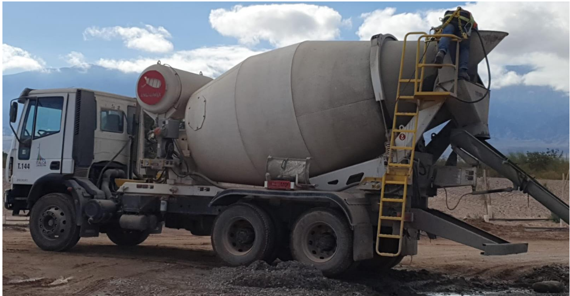
Imagen N° 11: Limpieza general del trompo en la cava.
