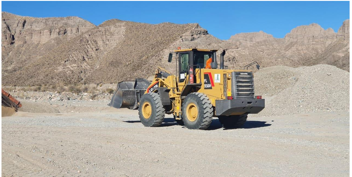
Imagen N° 5: Limpieza del material áridos.
