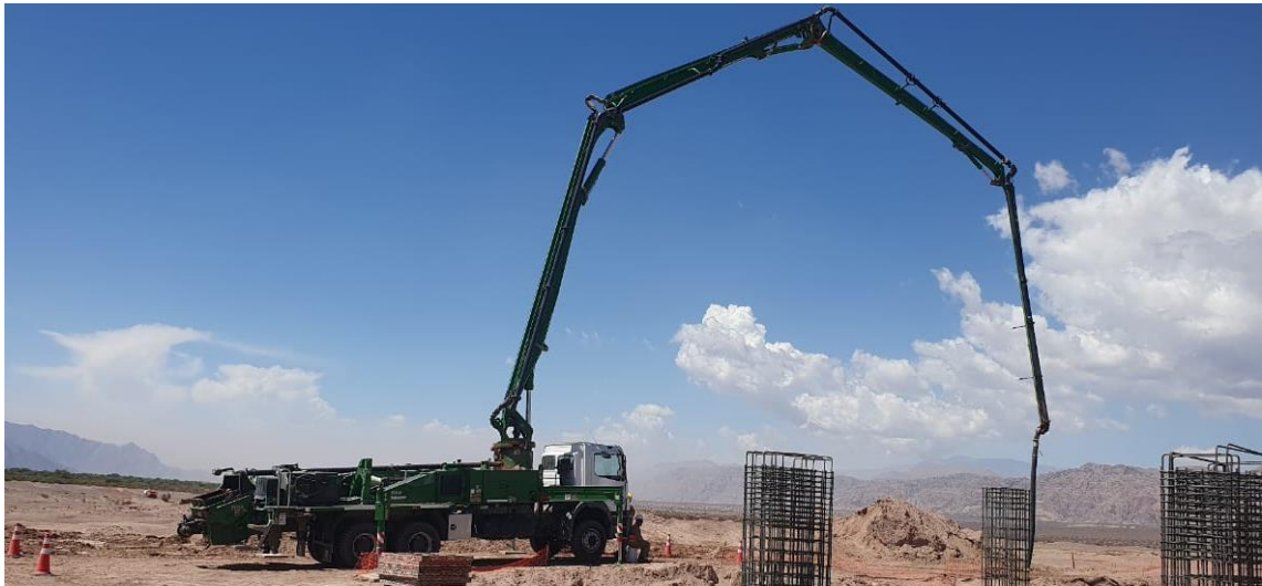
Imagén N° 9: Camión con bomba telescópica.
