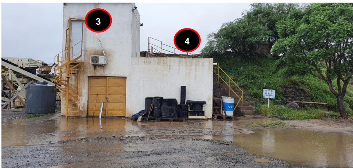
Imagen N° 31: Área de la Planta de Trituración.
