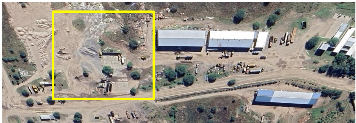
Imagén N° 4: Sector de la Planta Dosificadora de Hormigón, acopio de materiales y cava de limpieza.
