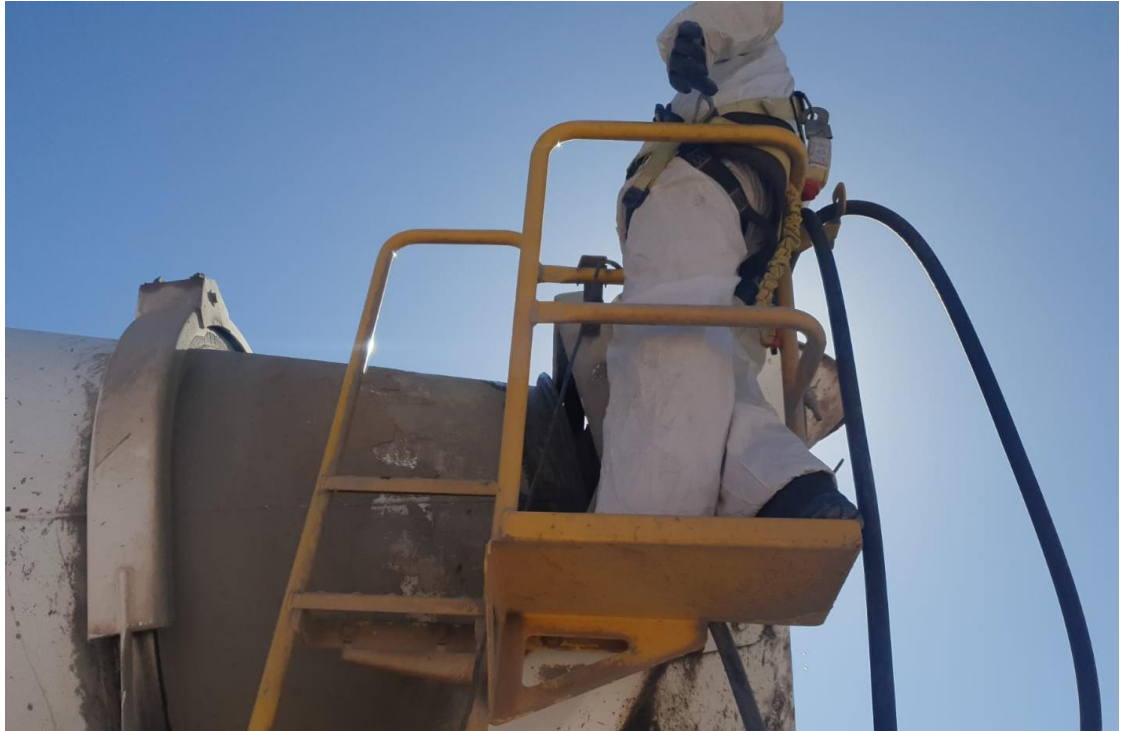
Imagen N° 17: En el lavado del trompo se expone a riesgos de atrapamiento y a caídas.
