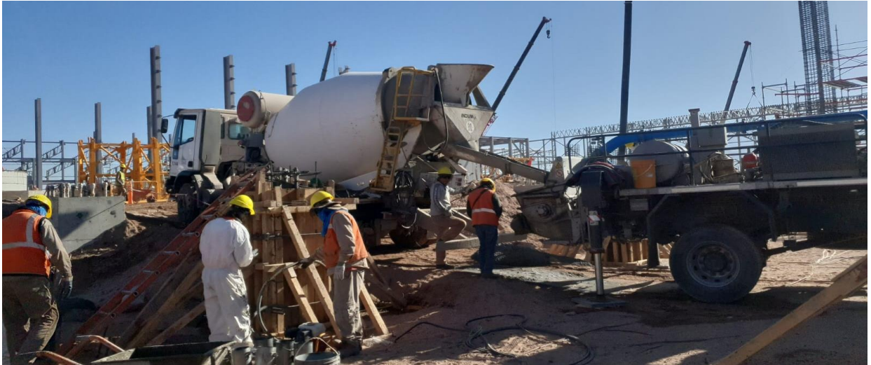
Imagen N° 8: Posicionamiento del camión para la descarga.
