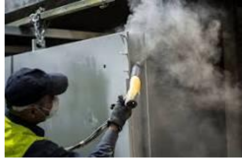
Aplicación de pintura
