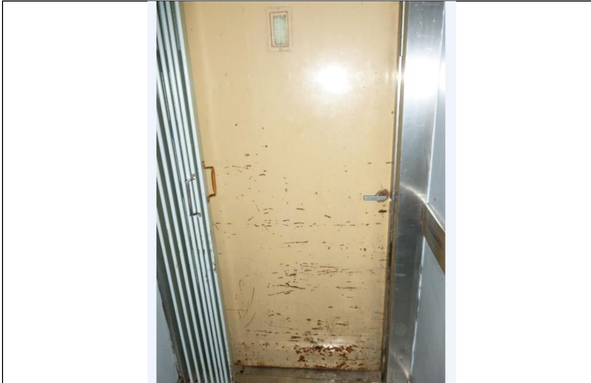
Foto 9: Puerta del ascensor antes de baja a la morgue
