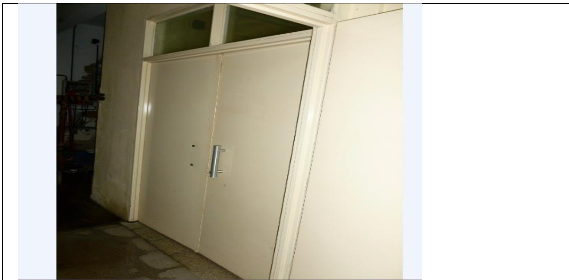
Foto 10: Puerta del lado del salón de la morgue propiamente dicho, y muestra la ventana fija.
