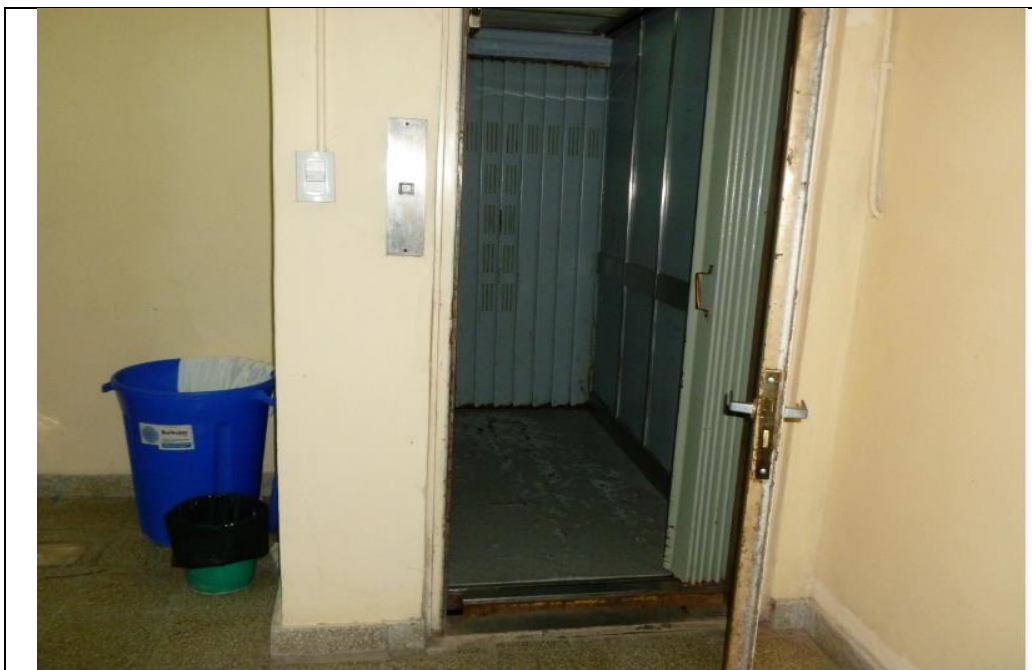
Foto 8: Puerta del ascensor dentro de la morgue propiamente dicho
