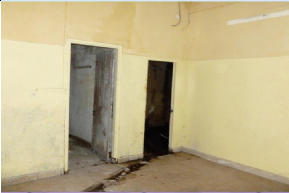
Foto 5: Puertas de las 2 habitaciones que desembocan al salón del subsuelo
