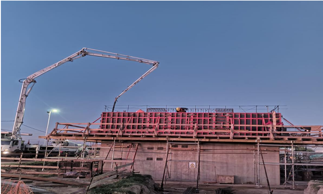
Encofrado y hormigonado con bomba
