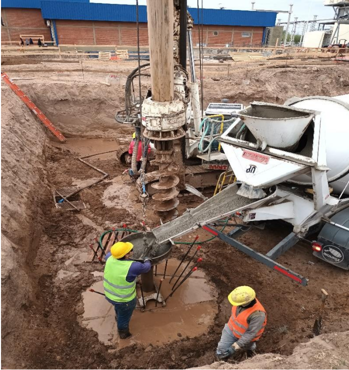
Hormigonado de pilote
