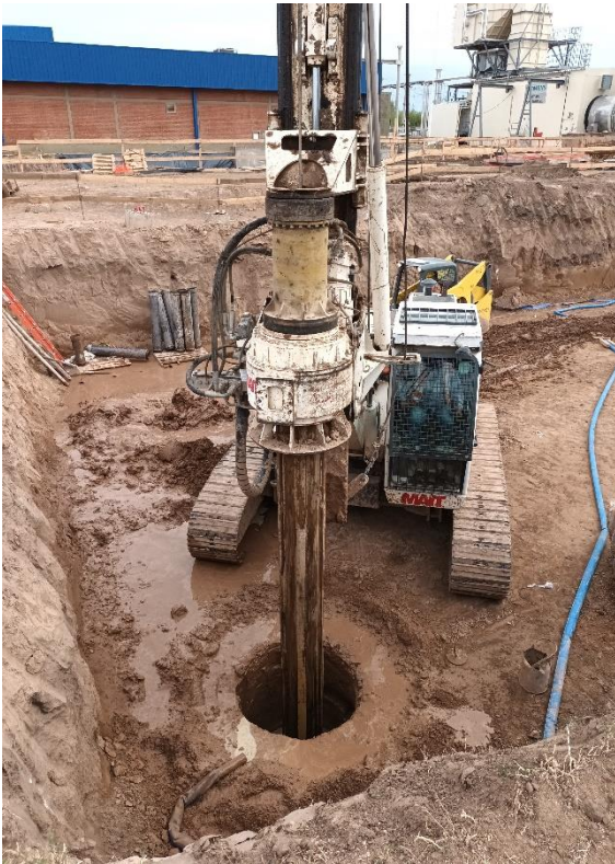
Retiro con balde de tierra mezclada con bentonita
