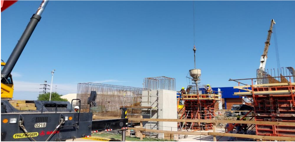
Encofrados y hormigonado
