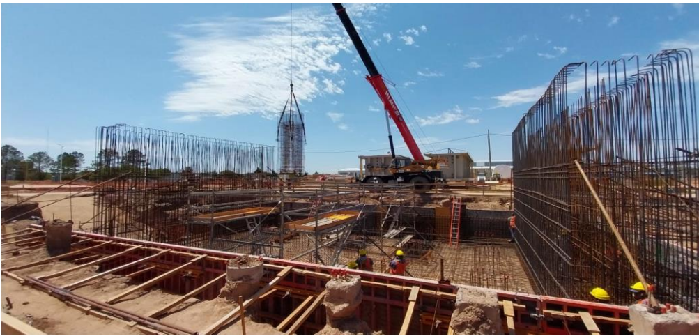
Montaje de armaduras
