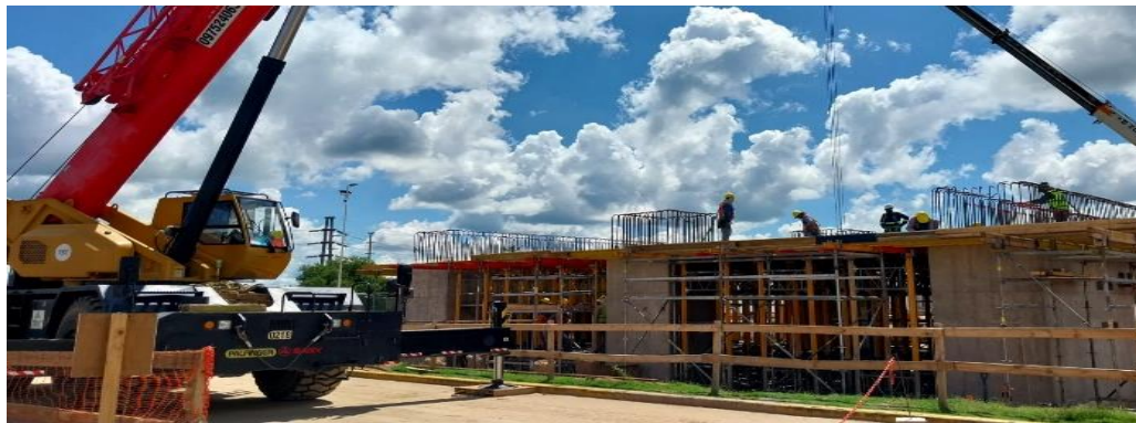
Encofrado de losa
