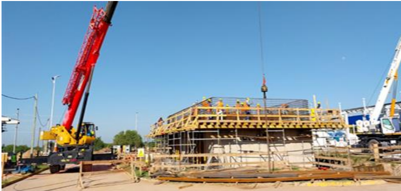
Armadura de losa
