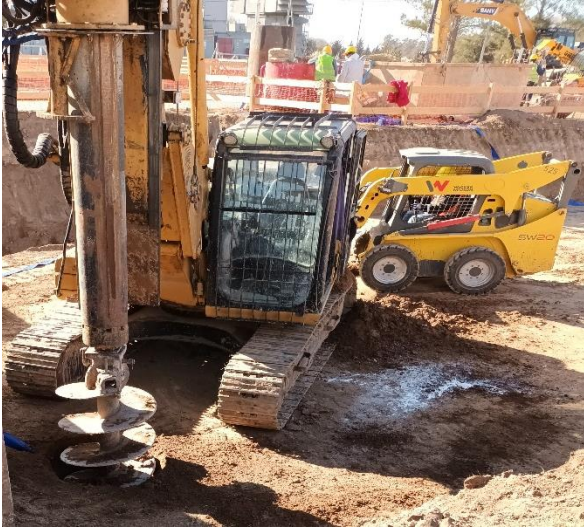
Perforación de pilote con mecha
