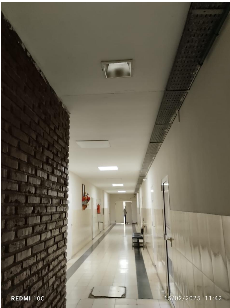
Puerta de salida planta Baja
