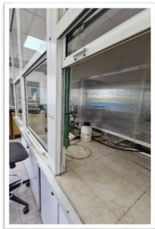
Ilustración 34 - Las cabinas no se encuentran aisladas unas con otras
