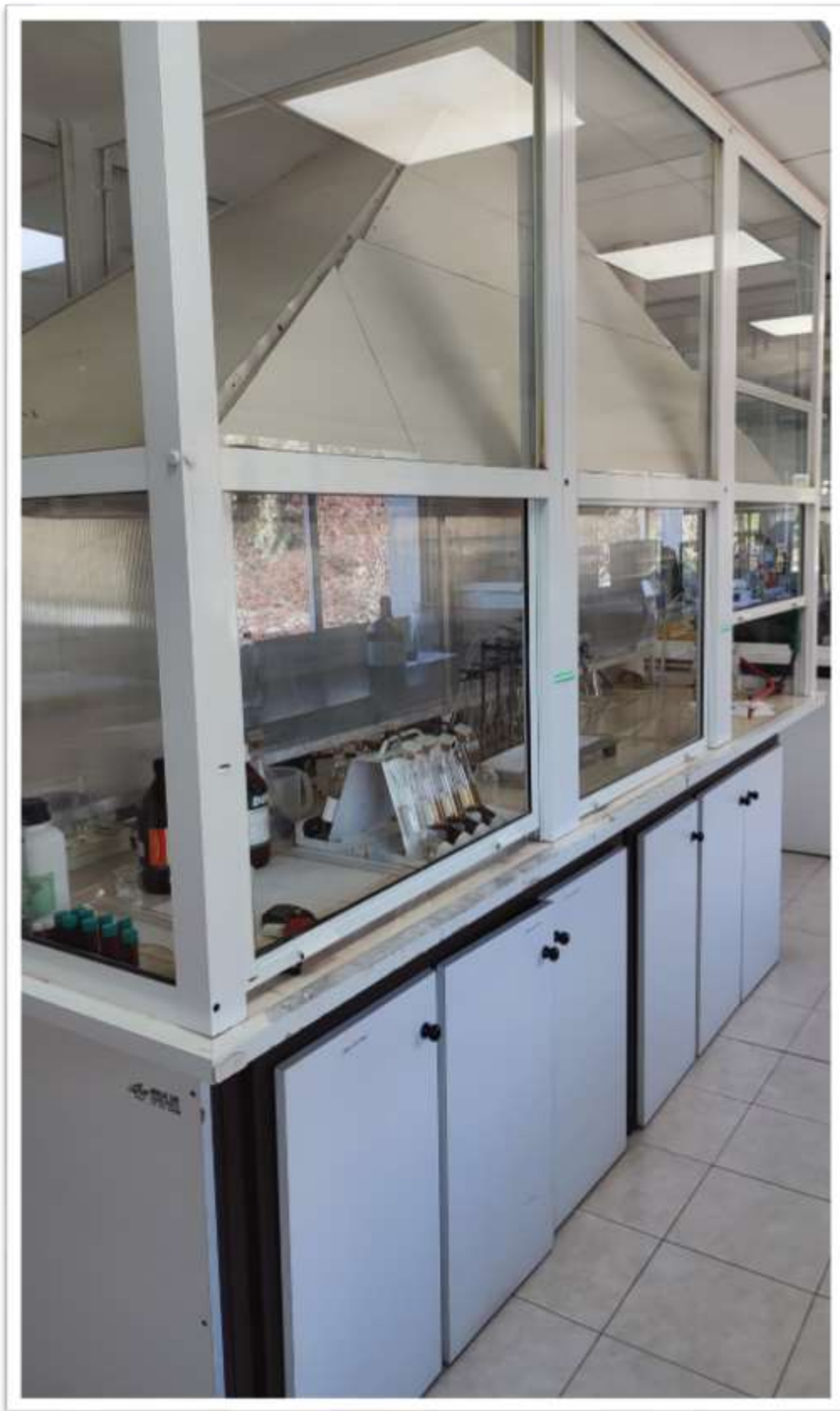
Ilustración 8 - Sala de cabinas de extracción
