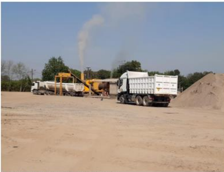
Fig.9: Camión batea, camión tatu y mezcladora
