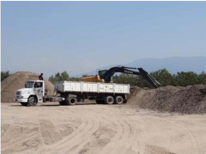
Fig. 2: Camión de carga y excavadora
