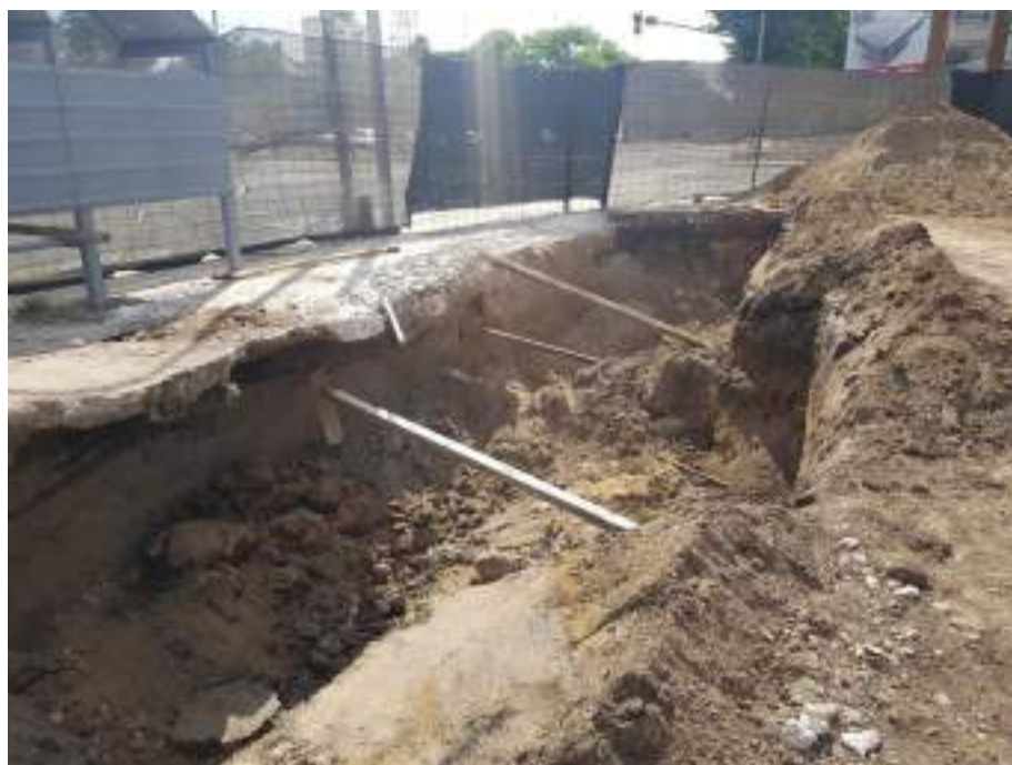
Ilustración 37: Área excavación y retiro Tanques N°2, 3 y 4 (Fuente: CPC MSaA.)
