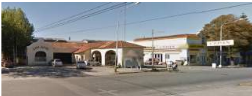
Ilustración 14: Predio en estado original, vista esquina Av. 59 y calle 52. (Fuente: Google maps)
