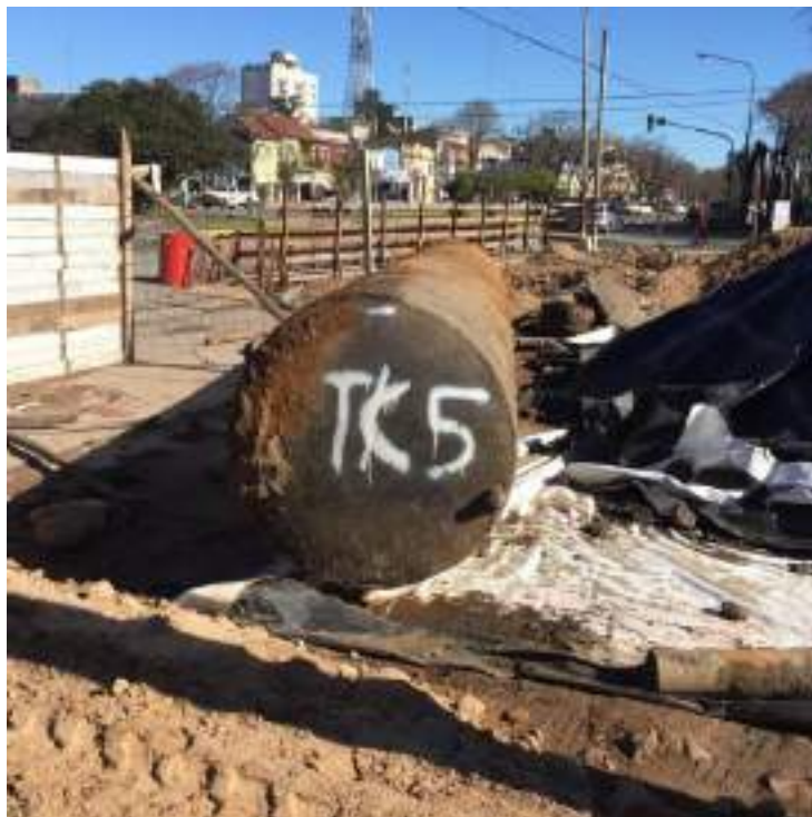
Ilustración 43: Detalle tanques extraídos (Fuente: CPC MSaA.)
