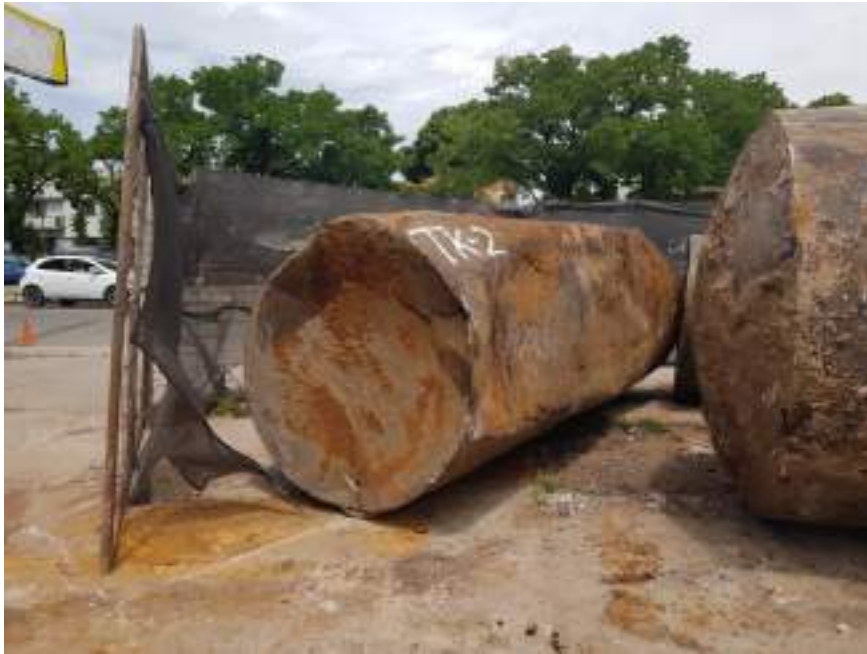
Ilustración 42: Detalle tanques extraídos (Fuente: CPC MSaA.)
