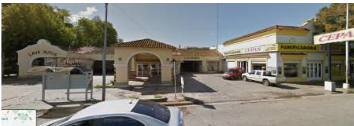
Ilustración 15: Predio en estado original, vista de Av.59. (Fuente: Google maps)
