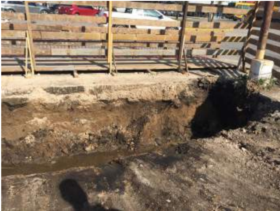
Ilustración 39: Fosa generada extracción TK-5 (Fuente: CPC MSaA.)
