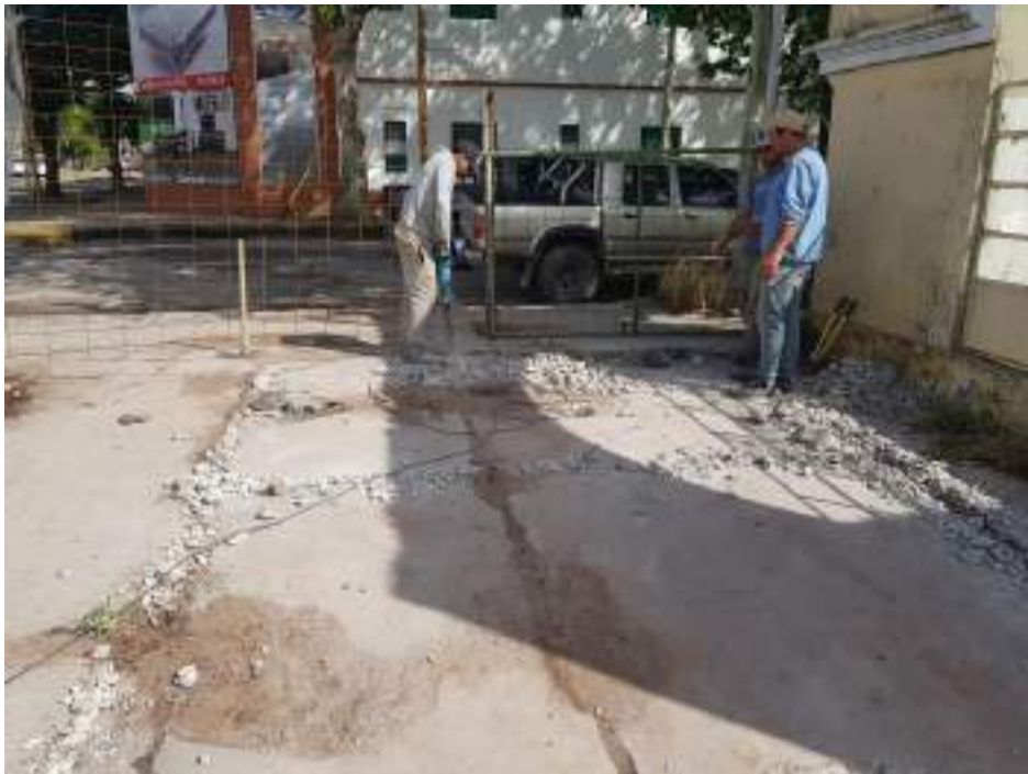
Ilustración 33: Delimitación área de rotura TK 1 (Fuente: CPC MSaA.)
