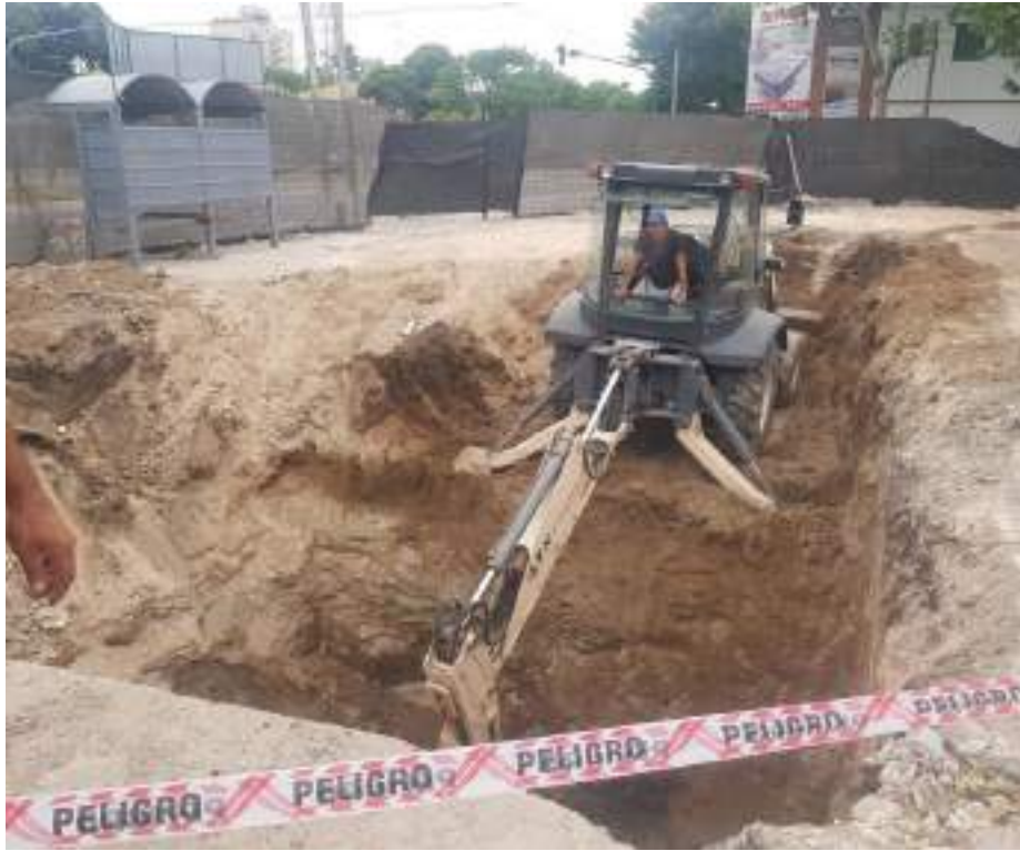
Ilustración 38: Excavación área de islas de expendio (Fuente: CPC MSaA.)
