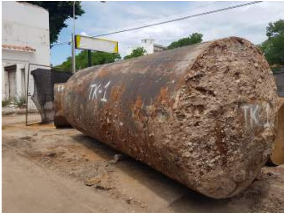
Ilustración 41: Detalle tanques extraídos (Fuente: CPC MSaA.)
