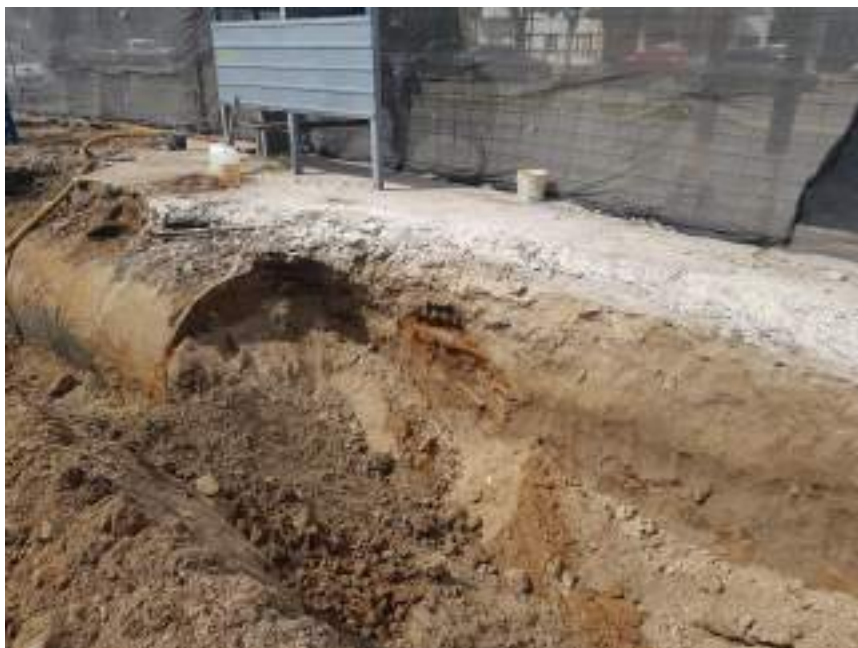
Ilustración 36: Área excavación y retiro Tanques N°2, 3 y 4 (Fuente: CPC MSaA.)
