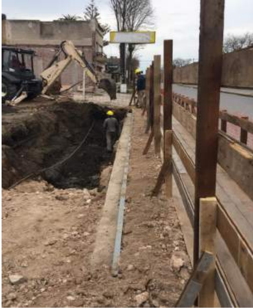
Ilustración 40: Fosa área de surtidores sobre vereda (Fuente: CPC MSaA.)
