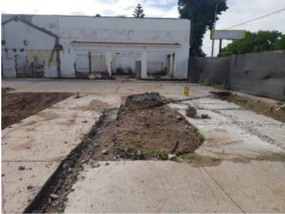
Ilustración 34: Vista general del Este, área de expendio (Fuente: CPC MSaA.)
