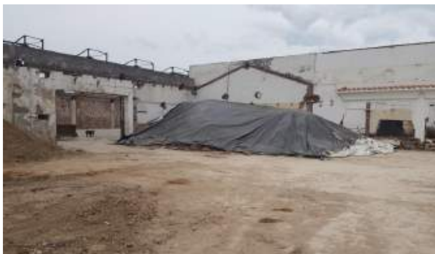
Ilustración 51: Área de acopio de material a disponer. (Fuente: CPC MsaA)
