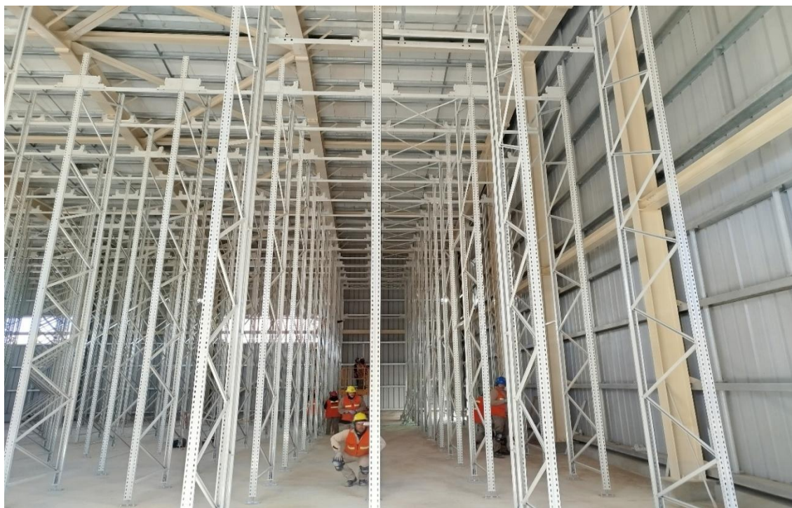
Figura 11: Alineación de estructura vertical
