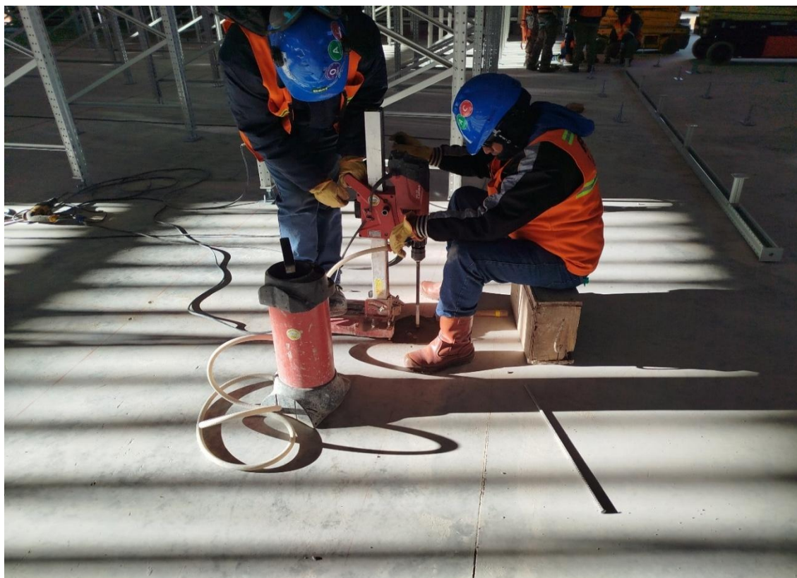
Figura 5: Perforación de suelo para anclaje químico
