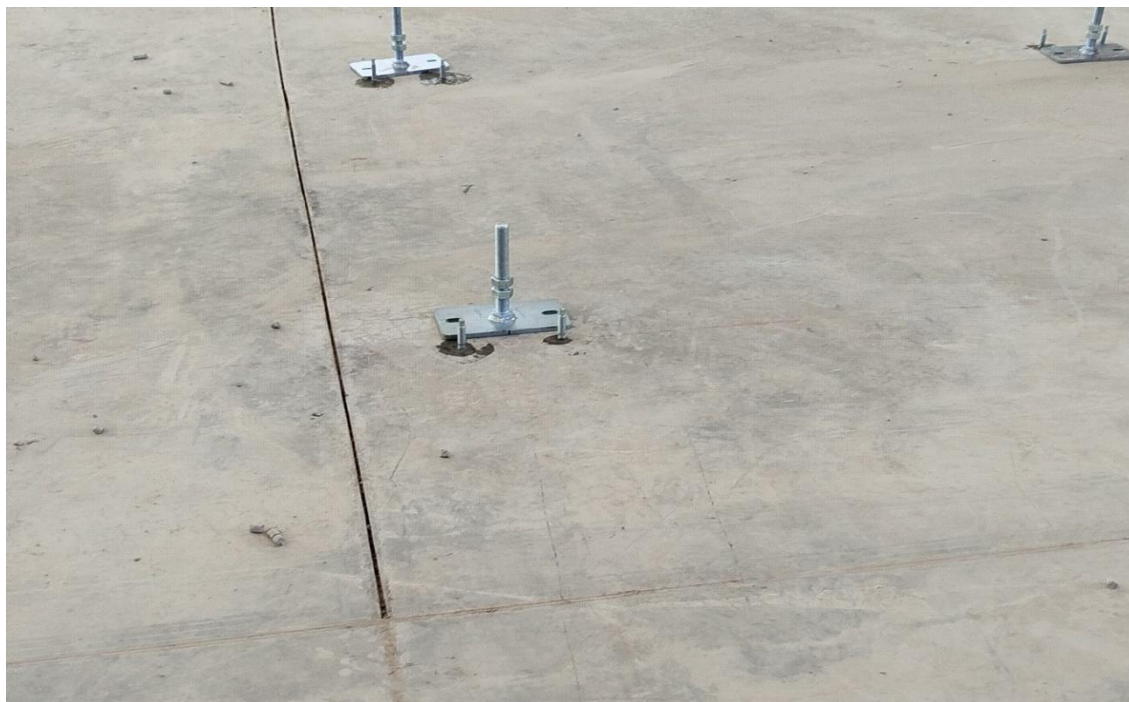
Figura 6: Anclaje químico colocado
