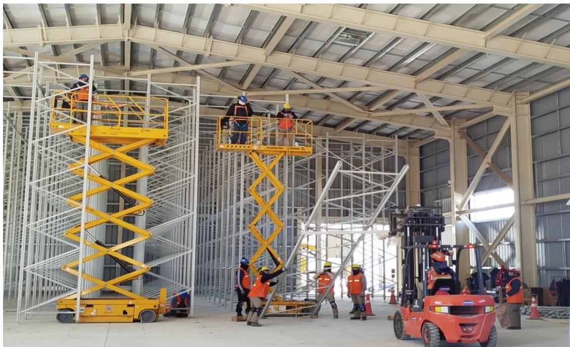
Figura 10: Utilización de equipos de elevación para instalación de niveles superiores
