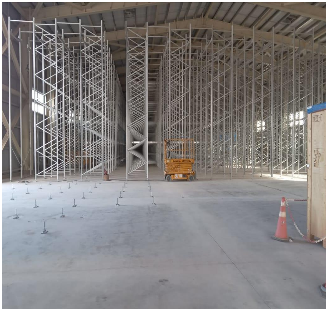
Figura 1: Interior de edificio donde se están montando las estructuras metálicas (racks)
