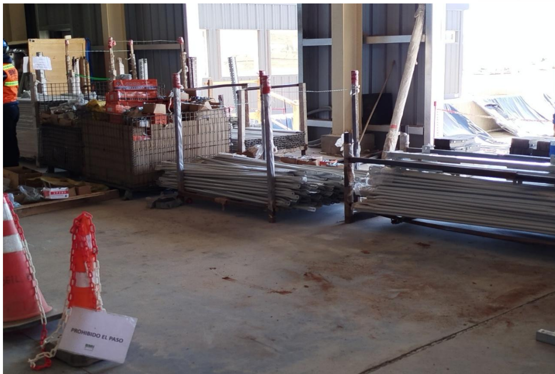
Figura 3: Acopio y separación de materiales
