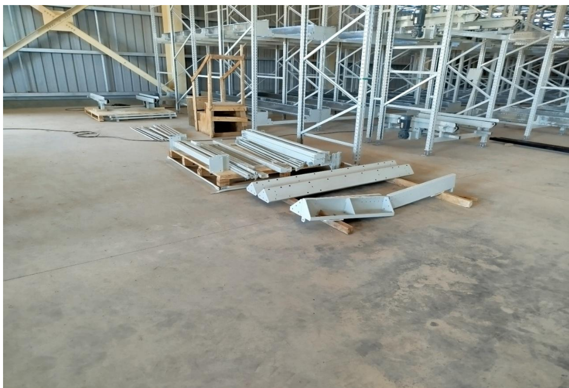
Figura 4: Acopio y separación de materiales
