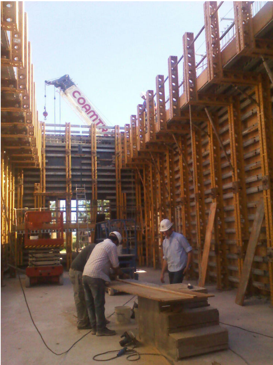
Fabricación de encofrados de paneles. Paredes internas y externas del simulador.
