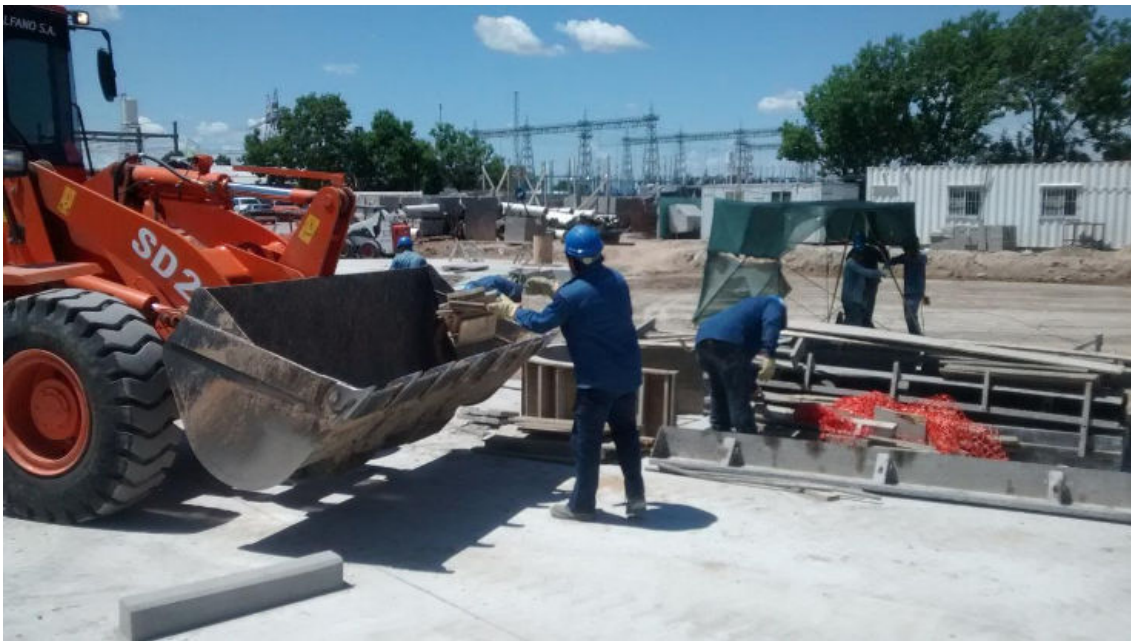
Orden y limpieza. Retiro de los acopios transitorios de materiales con una topadora.
