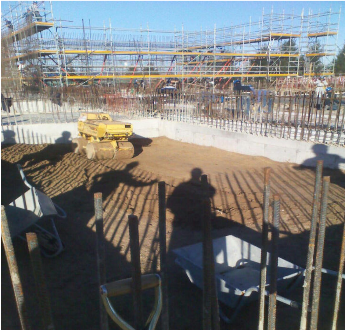
Compactación del piso del simulador.
