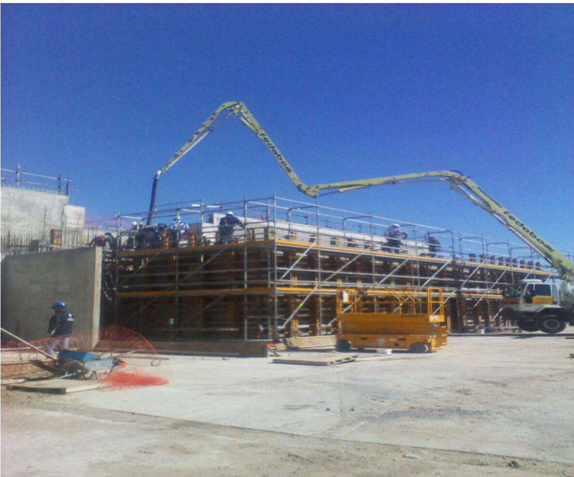
Hormigonado de tabiques con bomba pluma.
