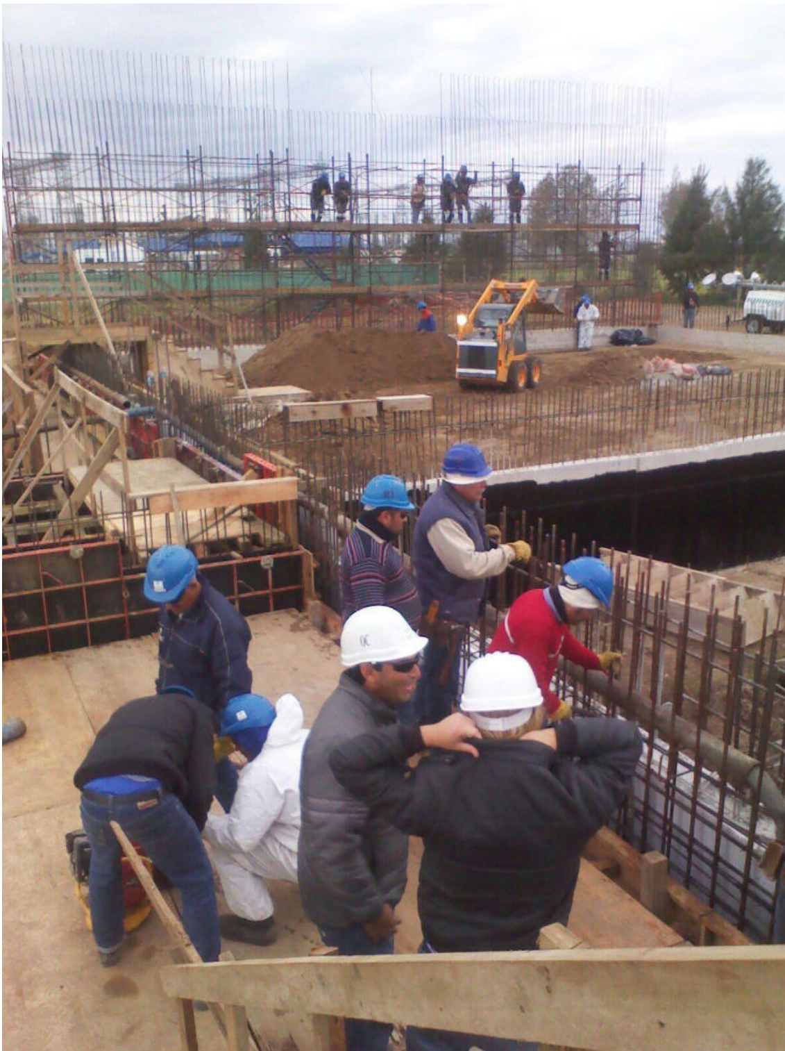
Nivelación del piso del simulador. Si bien el piso comienza en -1 , las bases se encuentran fundadas en -3 (metros del nivel del suelo).
