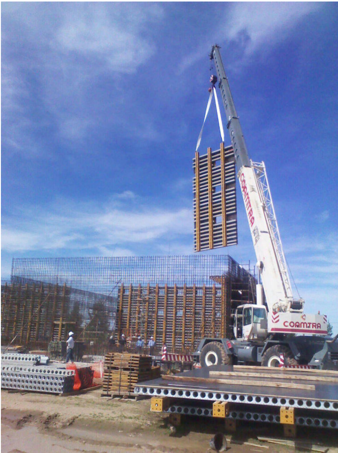
Montaje de encofrados con grúa. Son paneles especiales que se utilizan para este tipo de edificio, que cuenta con paredes de hormigón macizo.
