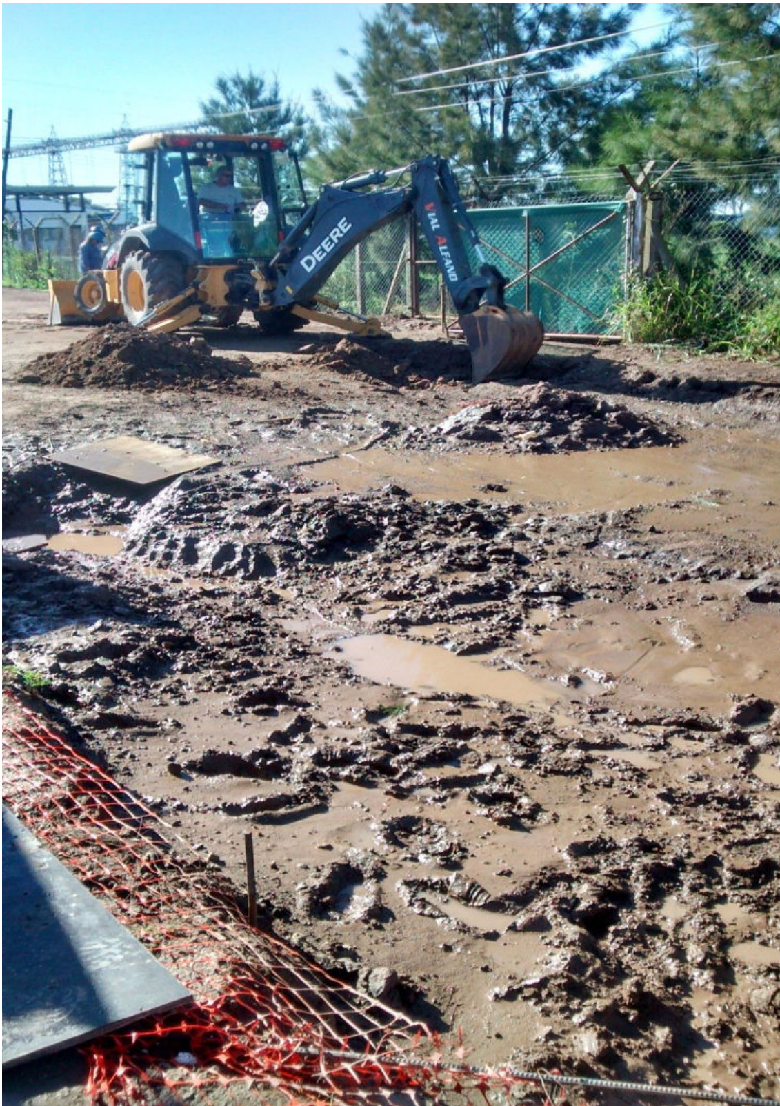
Movimiento y nivelación de suelo.
