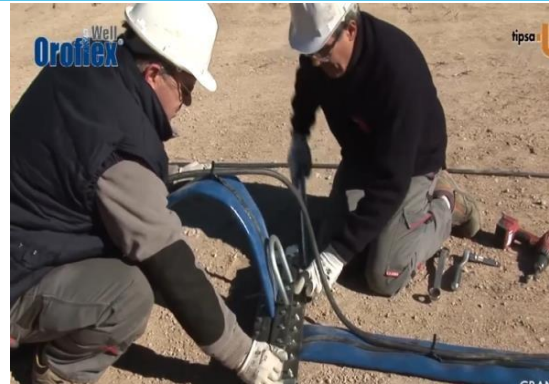
Reubicación de elevador por tramo
