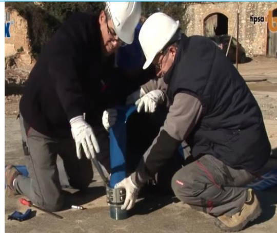
Corte y perfilado de extremo de manga
