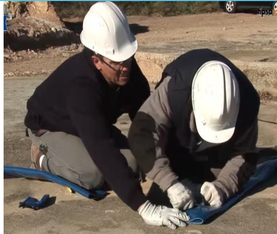
Corte y perfilado de extremo de manga
