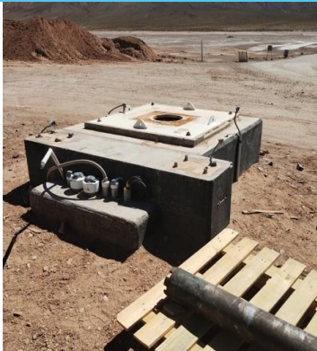
Pozo Productivo desmontado
