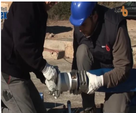
Vinculación a brida de Bomba de Succion.
