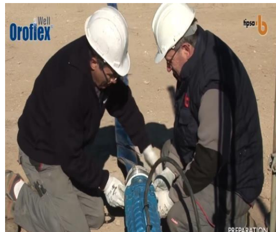
Vinculación de Bomba Electrosumergible
