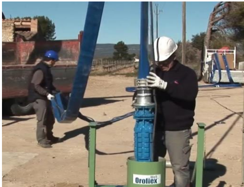
Maniobra de izaje a través de Hidrogrua
