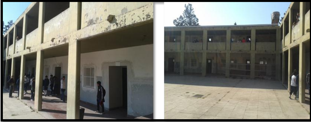
Fotos N° 17 y 18: Galería lateral de las aulas y galería trasera de las aulas
