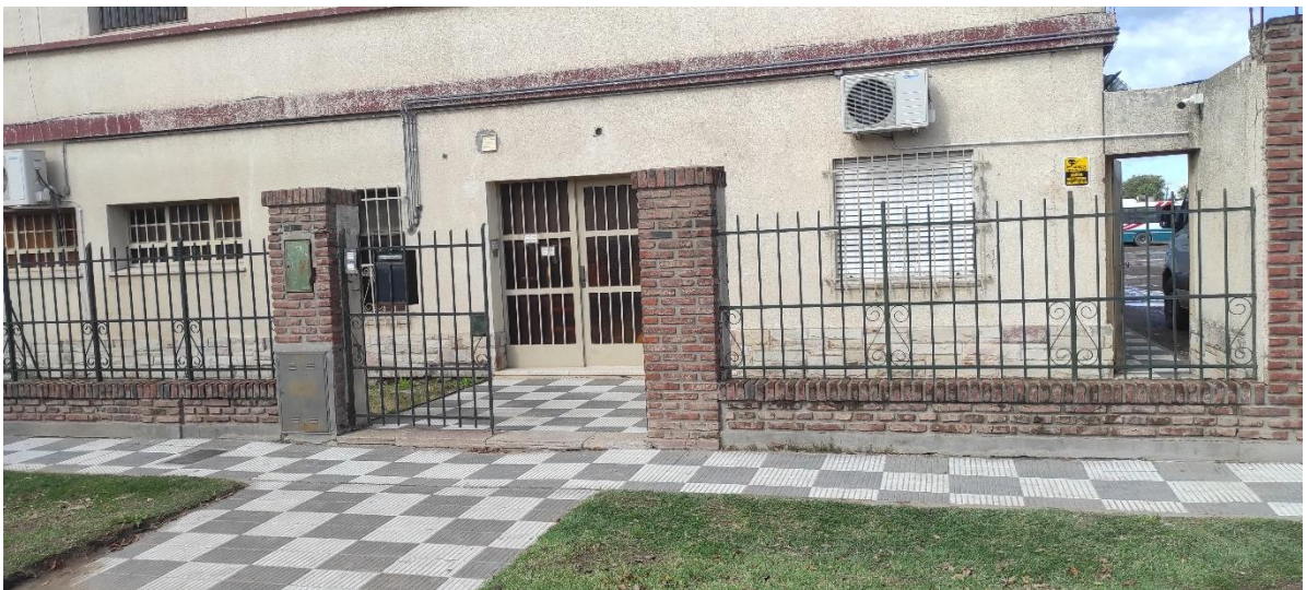
Frente del establecimiento: Oficinas administrativas
