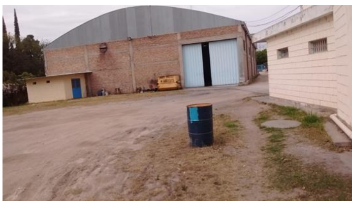
Vista desde el contra frente del establecimiento hacia su frente.
