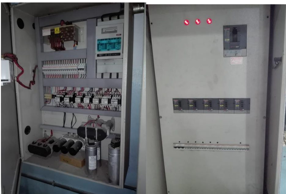
Fotografía n° 4: T.G.B.T con su llave seccionadora general y cinco llaves seccionadoras secundarias. Tablero General de corte y protecciones.
