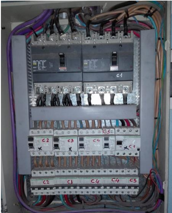
Fotografía 5: Tablero Secundario n° 3, tornos y fresas Tablero, dispositivos maniobra y protección – conductores. Imagen infrarroja: Temperatura normal.
