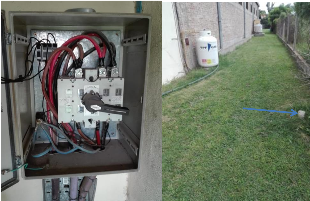
Fotografía n° 4: T.G.B.T con su llave seccionadora general y cinco llaves seccionadoras secundarias. Tablero General de corte y protecciones.
