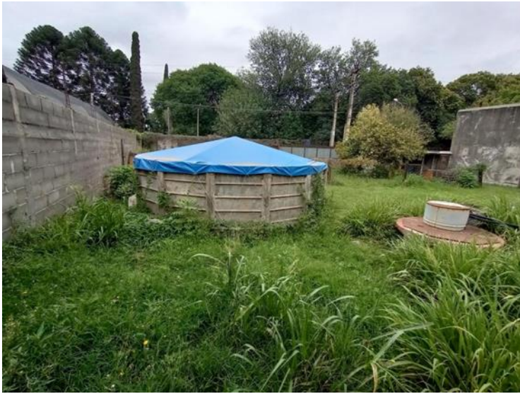
FOTOGRAFIA nº 7: en ésta, se observa la “Reserva de agua” exclusiva contra incendio, con yuyos altos.
