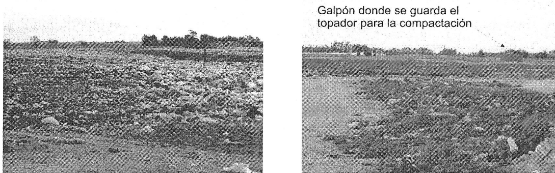
Figura 29: A la izquierda se puede apreciar el estado en que se encontraba el sitio de disposición final previo al inicio de conversión. A la derecha se observa los trabajos de cobertura ya realizados y se aprecia la presencia de la vegetación y las instalaciones de los servicios del predio.
