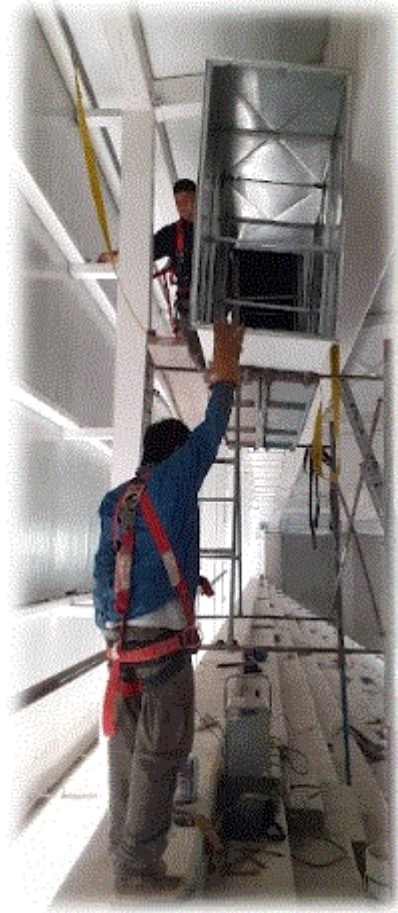
Fotos de trabajos en andamios de manera correcta e incorrecta operarios de JAF
