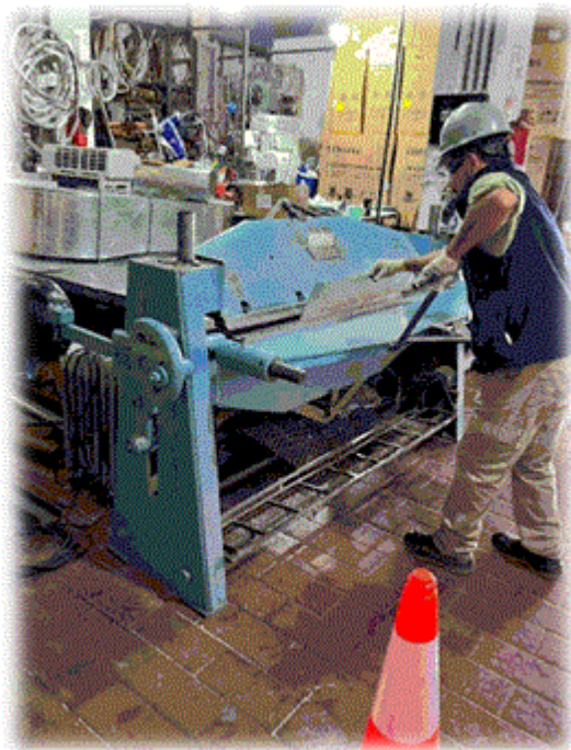
Imágenes de Operario de JAF realizando conductos de chapa
