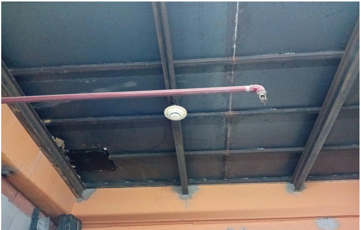
Ilustración 7 Detector de Humo y Rociador
