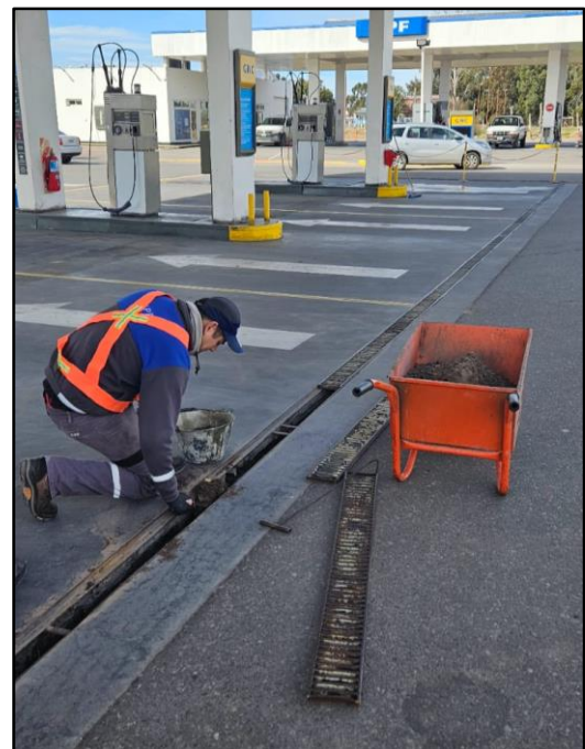
Extracción de canaletas sin elementos de seguridad y extracción de tierra en zona de GNC
