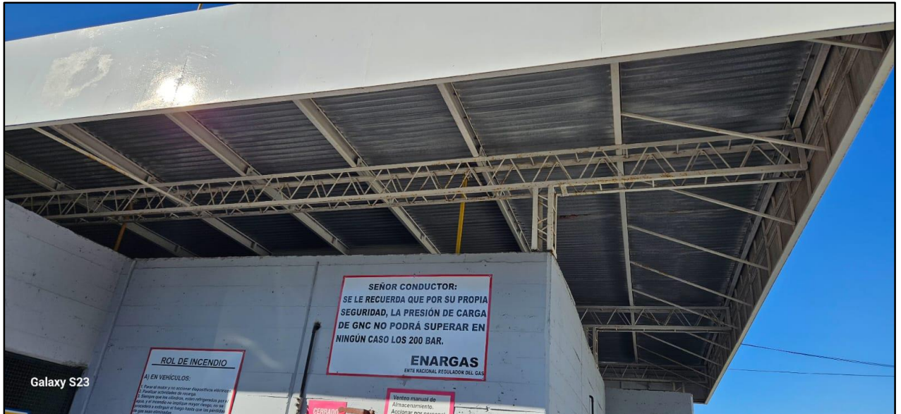
Vista del techo sobre elevado para ventilación.
