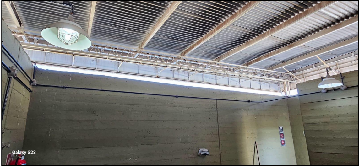
Vista interior del techo elevado.
