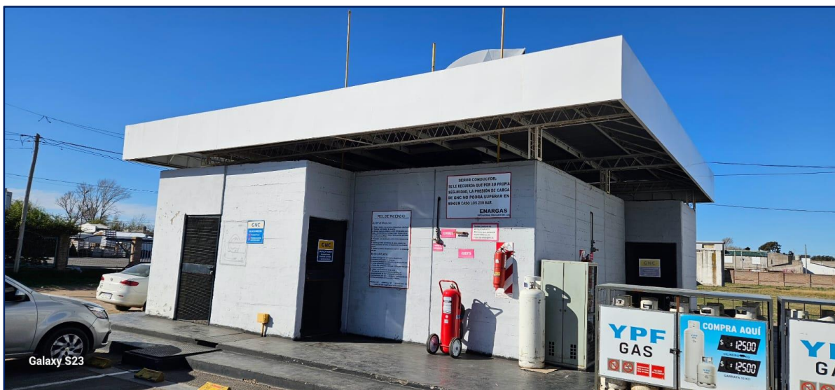
Edificio de planta compresora de GNC
