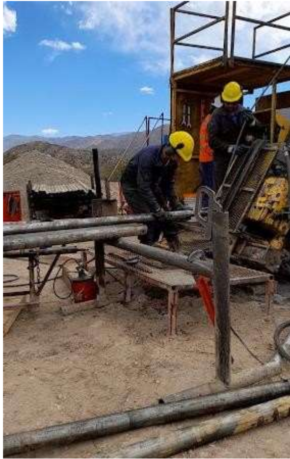
Boca de pozo realiza acople de barra
