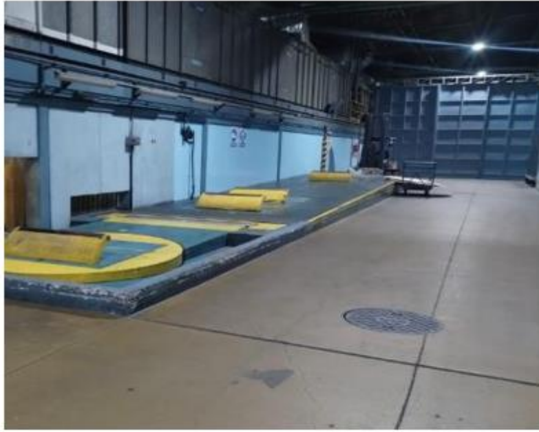
(Estación de decapado o pelado de bobinas)
