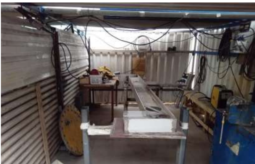
Carpa de trabajos en caliente
