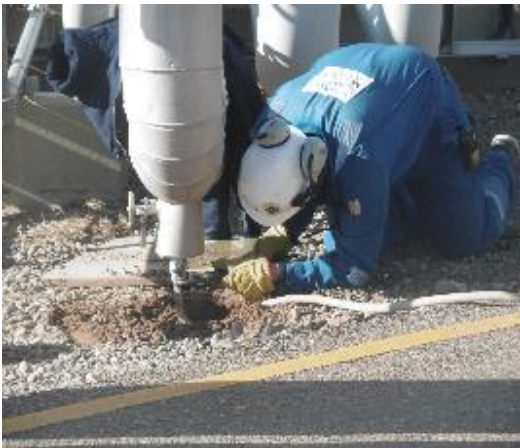
Inertizado de equipos
