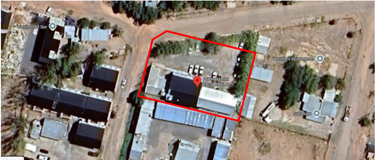
Imagen 3: Base Operativa Añelo, Lote 4 - Manzana B B° Industrial Añelo
