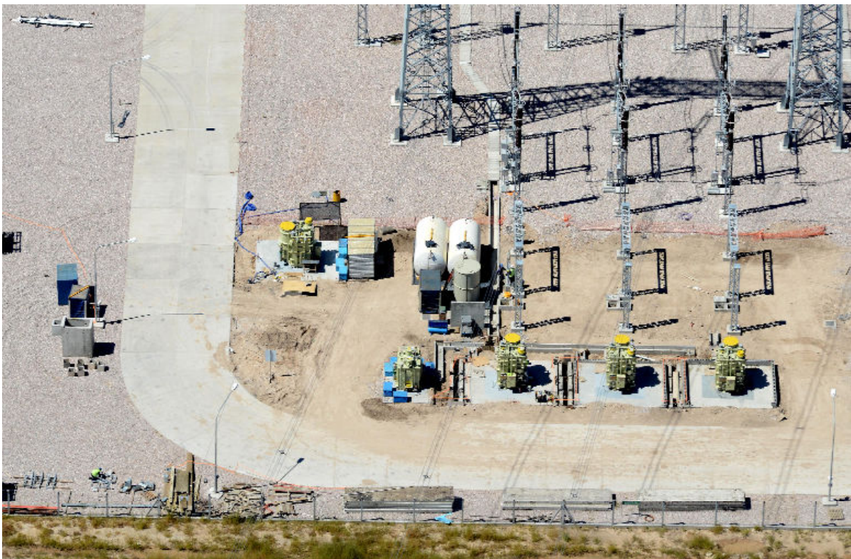
FOTO ET 500 KV SIN AMPLIACION (INSTALACION DE REACTORES CON SUS RESPECTIVOS TABLEROS DE COMANDO).
