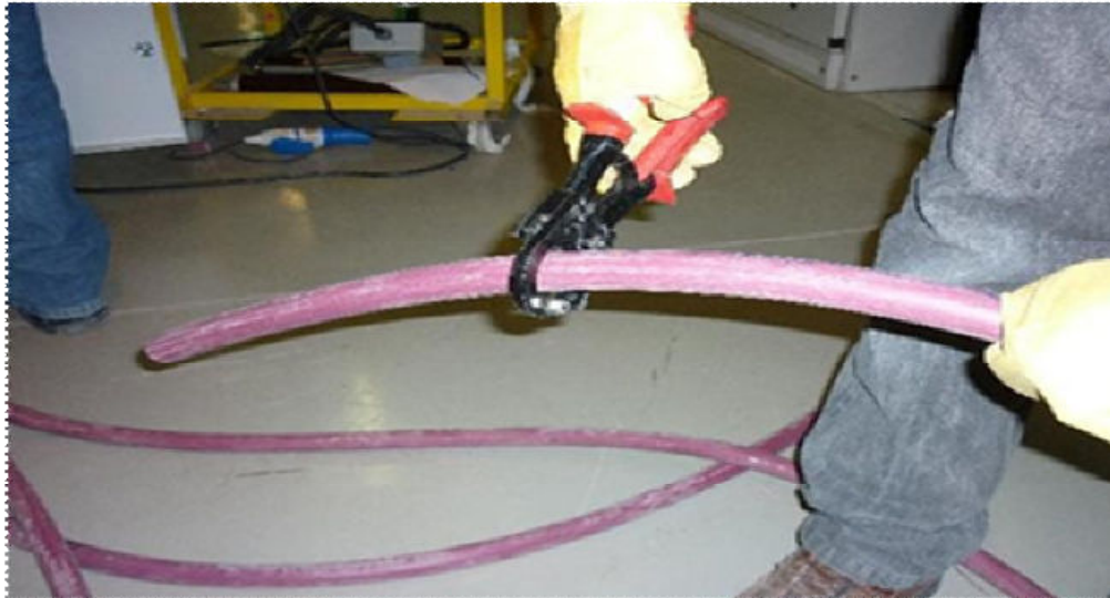
Foto 6: Utilización de cizalla para cortar cable conductor.
