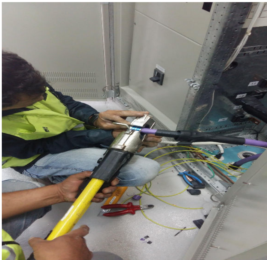
Foto 7: Uso de pinza de identar para colocación de terminales.
