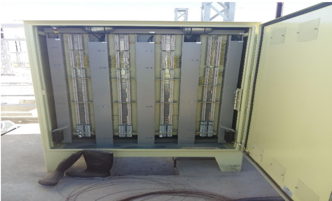
Foto 17: Tablero de comando de reactores.
