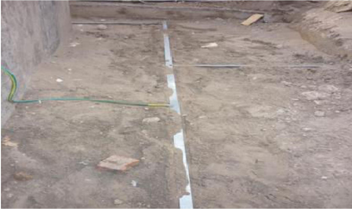
Foto 13: Vinculación de cable a malla de PAT.
