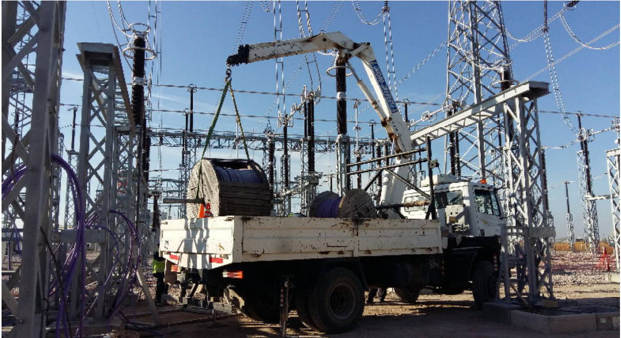
Foto 1: Traslado y bajada de bobina de cable
