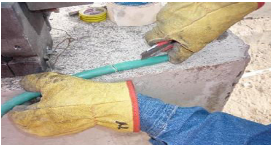
Foto 5: Corte de aislación utilizando cúter.
