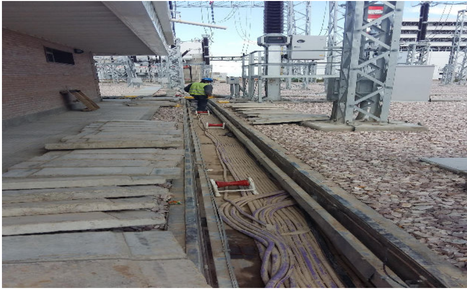
Foto 4: Acompañamiento del personal en el tendido de cable por canal.
