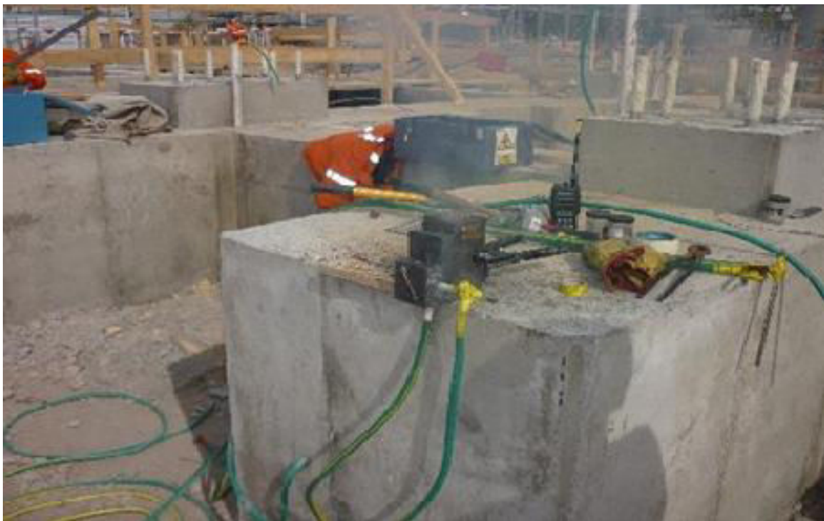
Foto 12: Momento donde se efectúa la soldadura.
