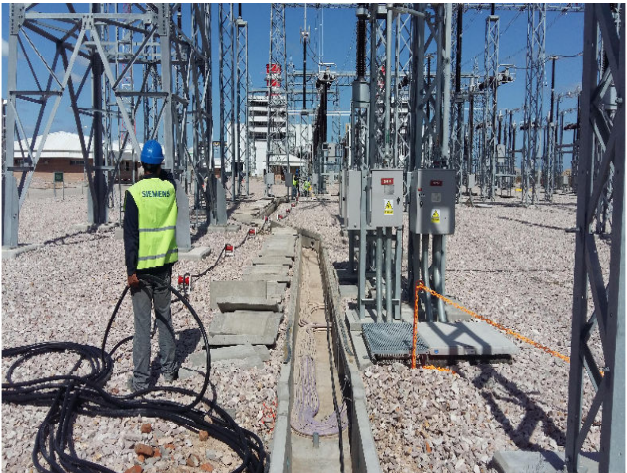
Foto 3: Tendido de cables por canal.
