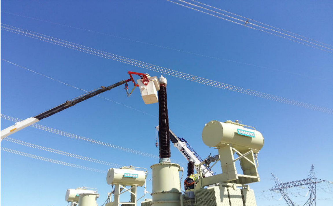
Foto 14: Conexión de Bushing.
