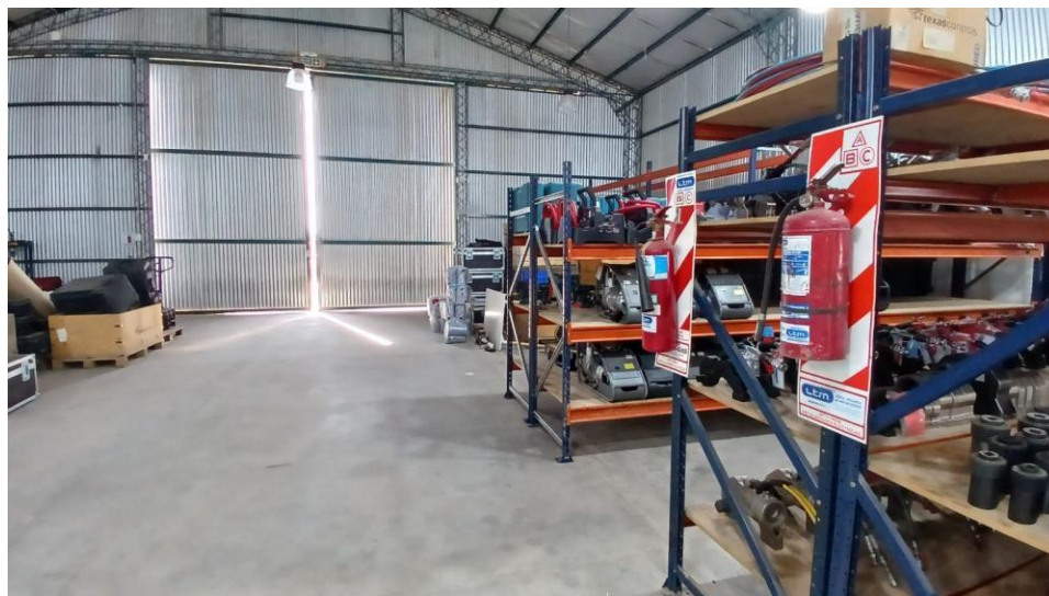
Extintores y Salida Trasera del taller
