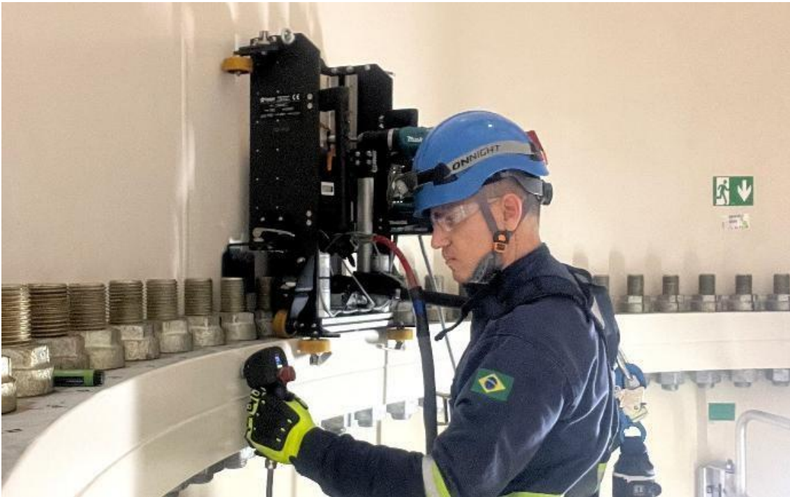
Técnico Electromecánico tensionando dentro de un Molino Eólico (Aerogenerador).
