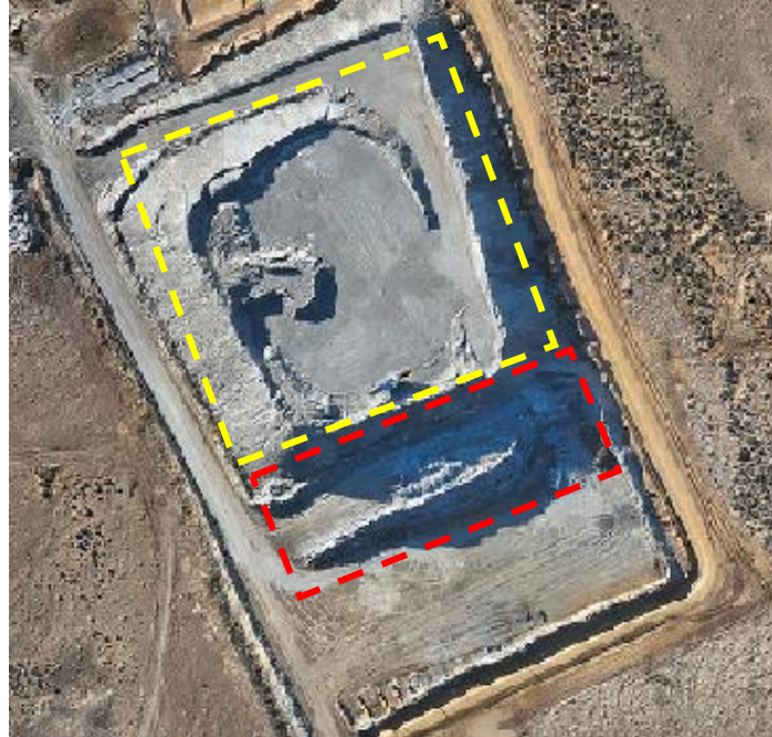
Imagen 9 Stock Pile San Marcos
