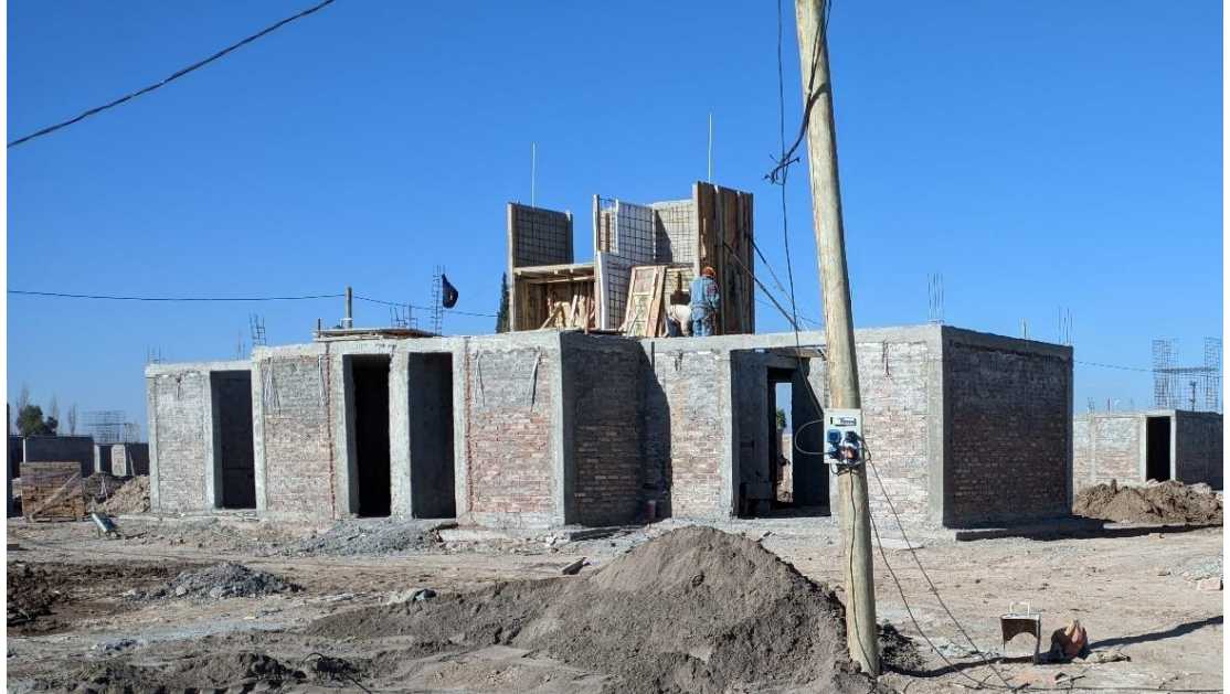
Imagen 3.2 montaje de encofrados
