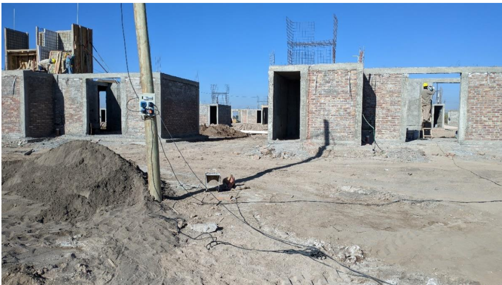
Imagen 4.12 tendido eléctrico en suelo
