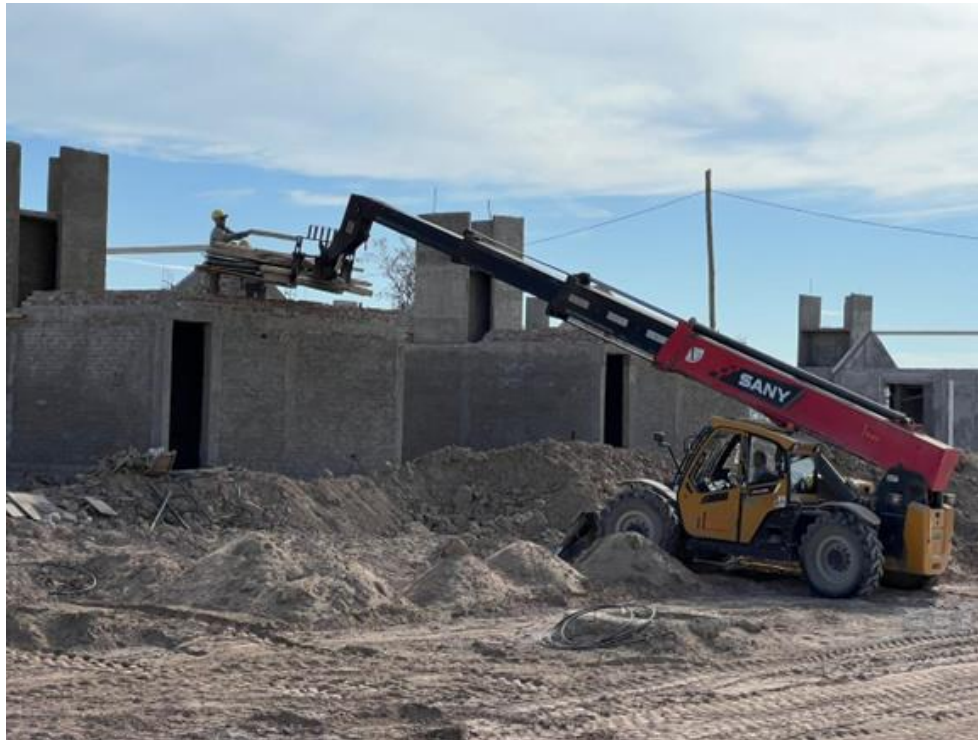
Imagen 3.6 Recepción de materiales en altura
