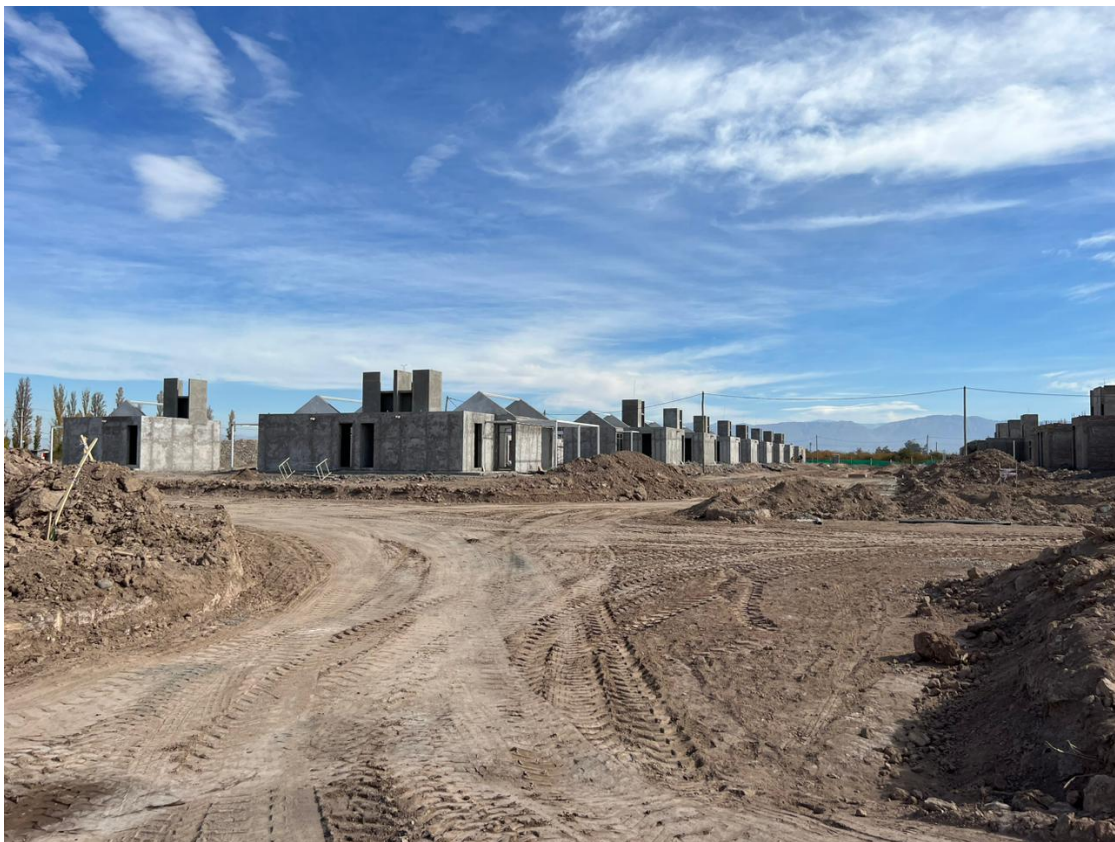
Imagen 1.2 Barrio en construcción Tehul
