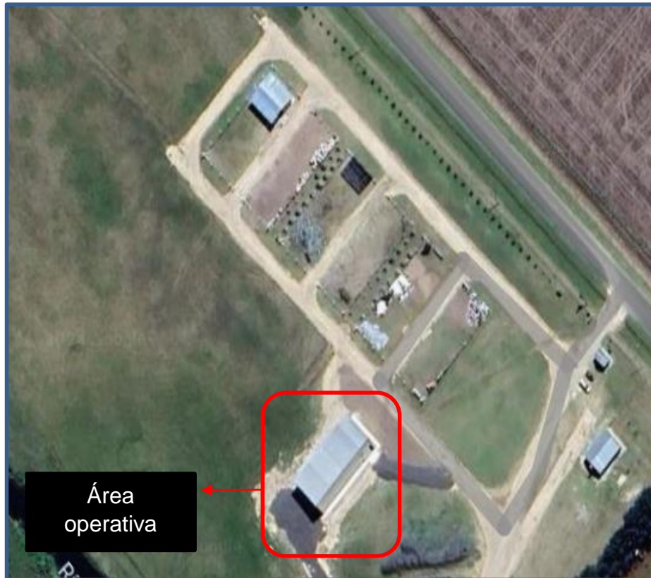
Imagen 2 Vista aérea de Planta SEMAR (Fuente: Google maps)
